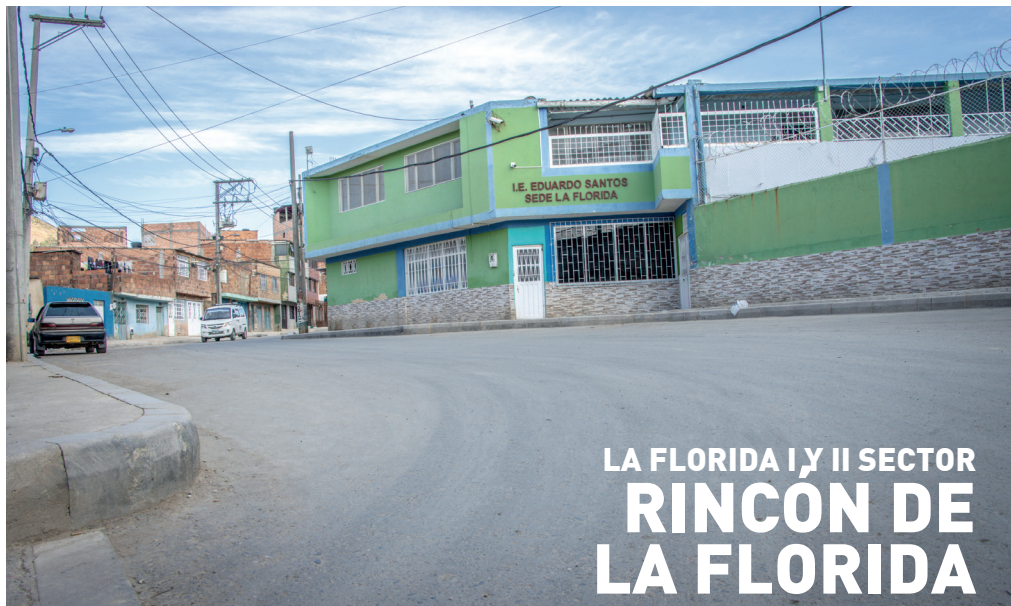
Mantenimiento en la malla vial.
