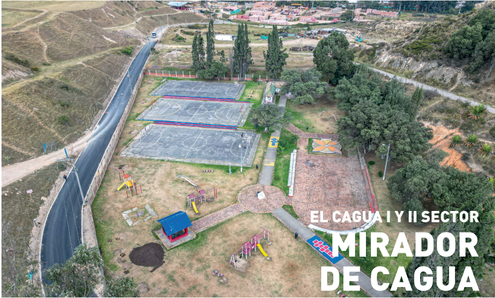
Adecuación del Parque Cagua.
