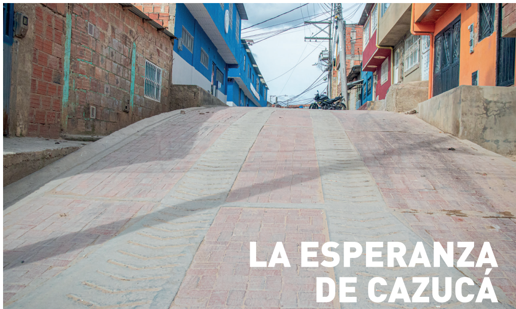
Intervención vial en tubería y adoquín.
