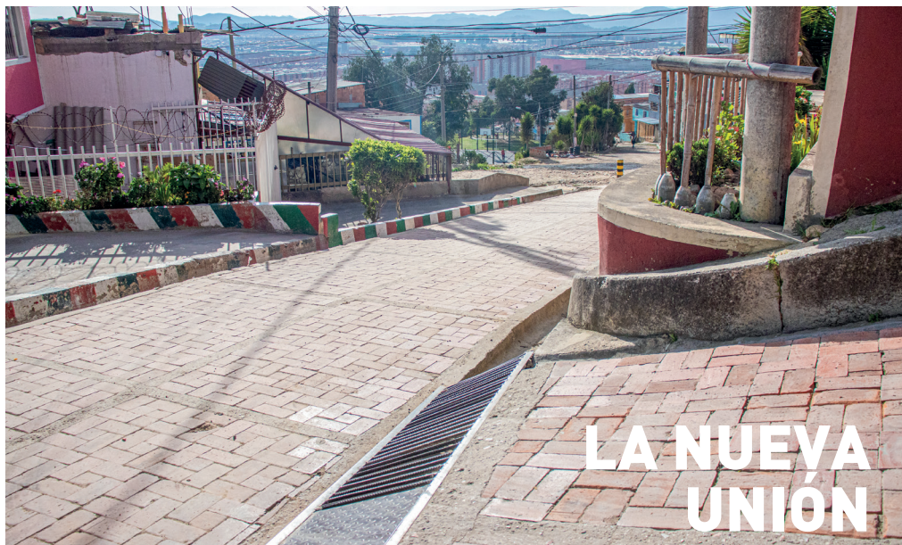
Intervención vial en tubería y adoquín.
