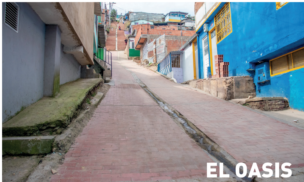
Intervención vial en tubería y adoquín.
