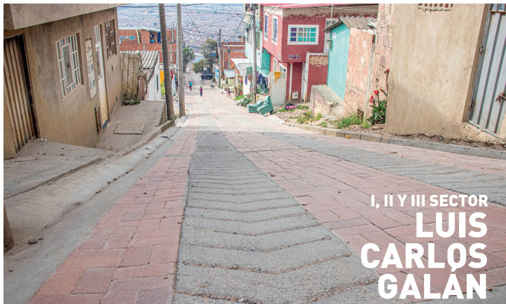
Intervención vial en tubería y adoquín.
