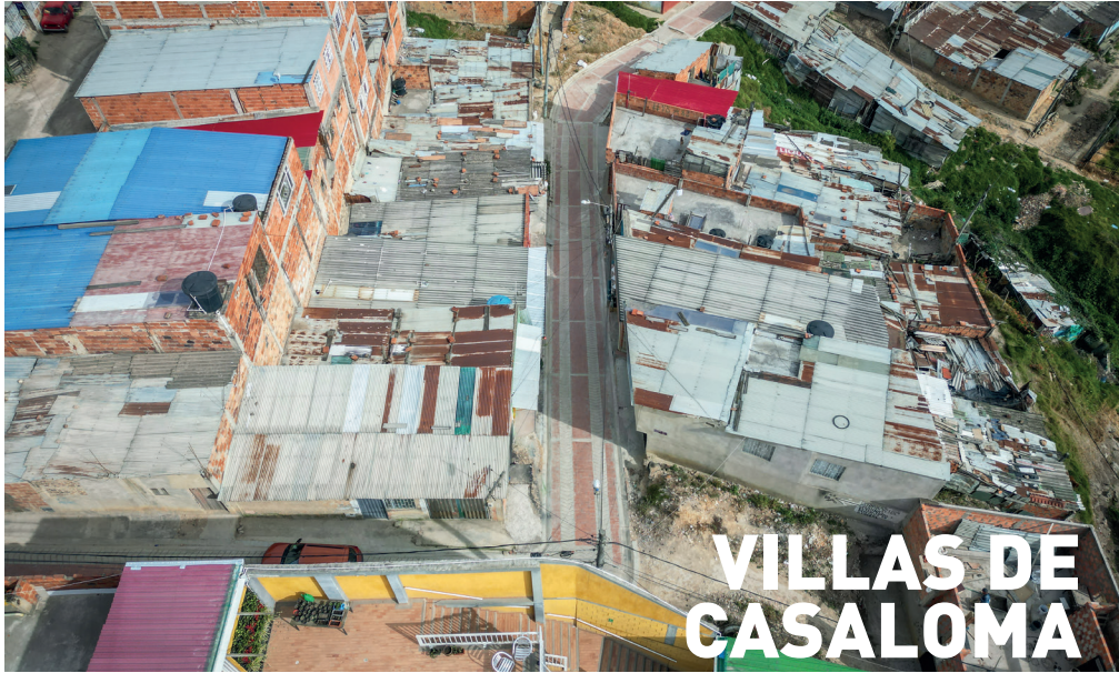
Intervención vial en tubería y adoquín.
