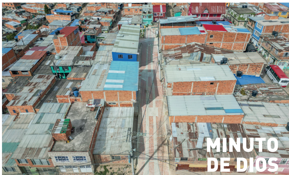
Intervención vial en tubería y adoquín.
