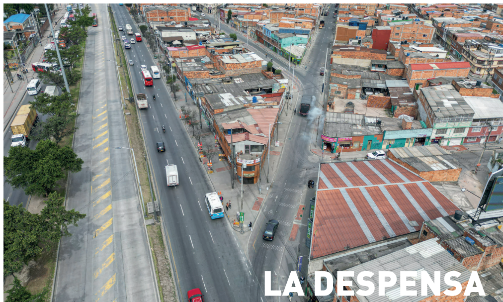
Mantenimiento en la malla vial.
