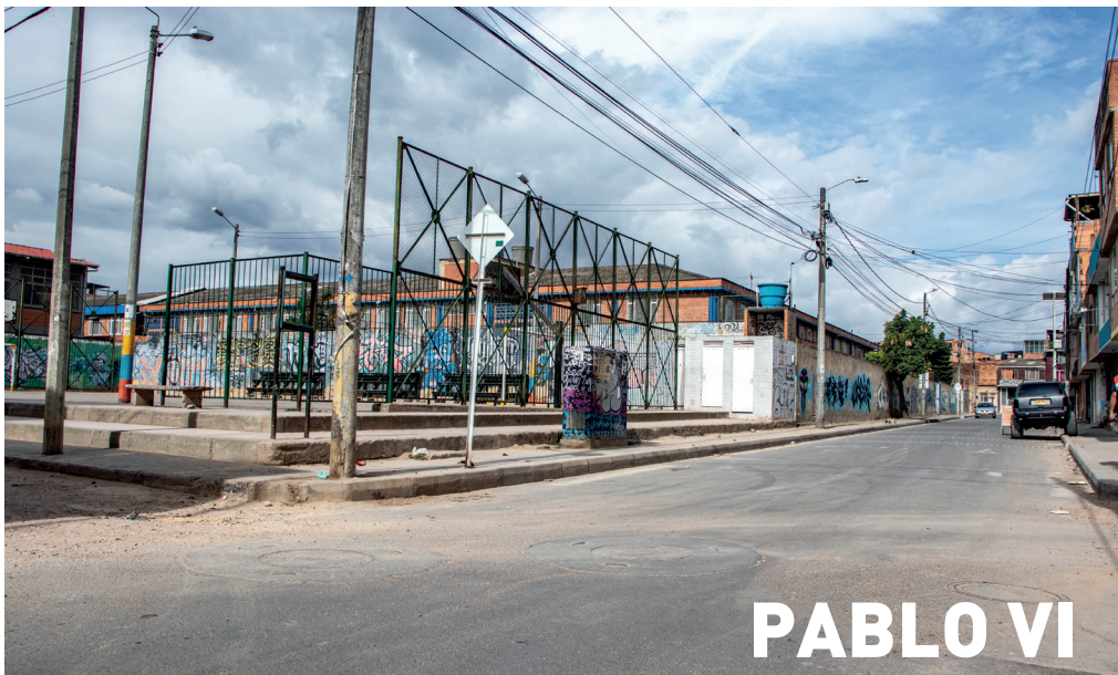
Mantenimiento en la malla vial.
