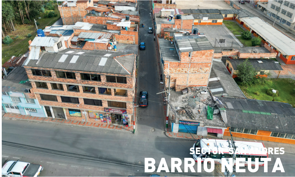
Mantenimiento en la malla vial.
