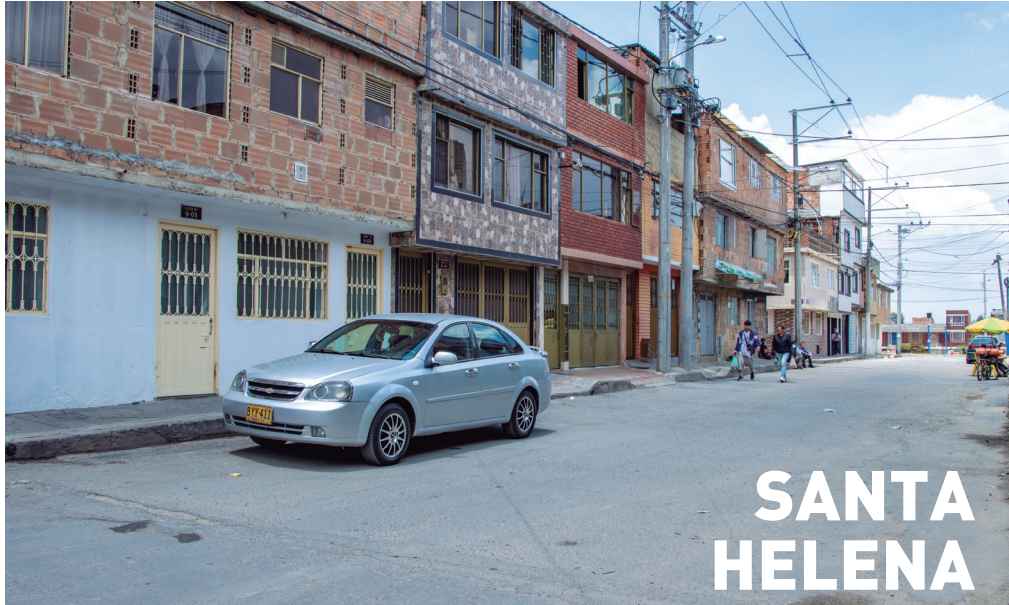
Mantenimiento en la malla vial.
