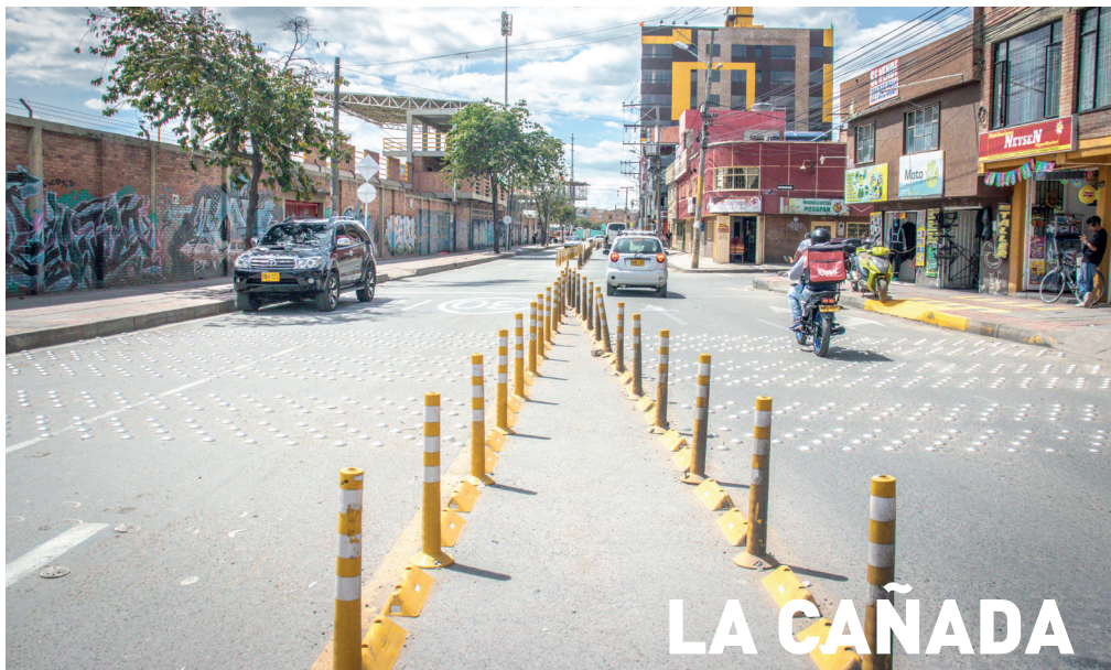
Señalización vertical y horizontal.
