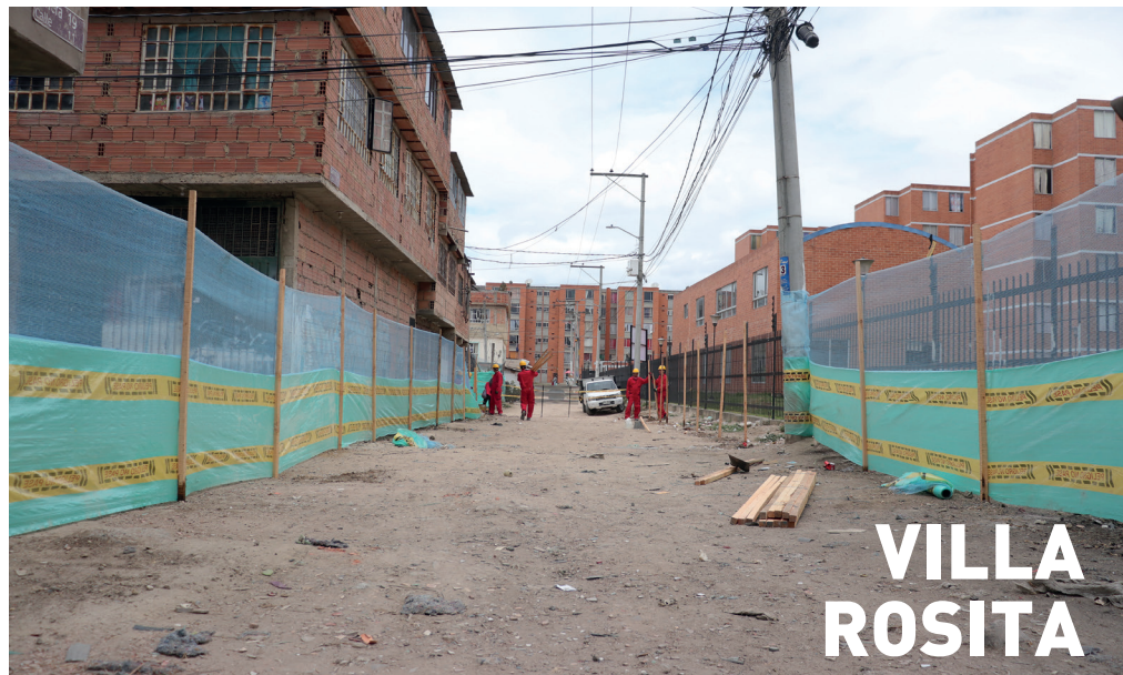
Renovación de redes de alcantarillado.
