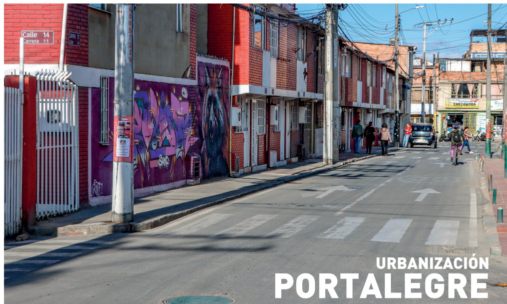
Mantenimiento en la malla vial.
