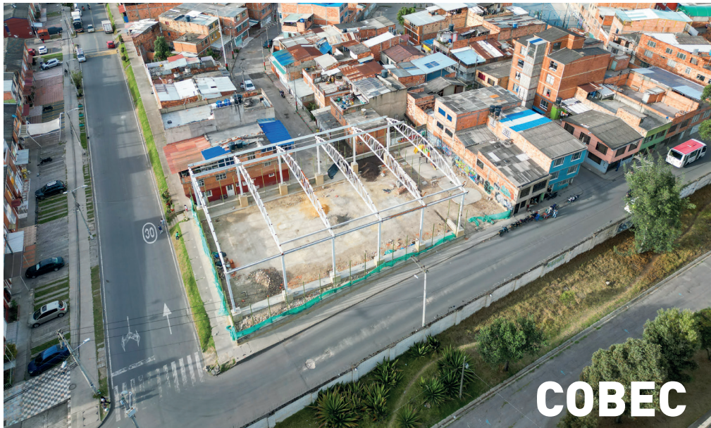
Construcción del Parque COBEC.
