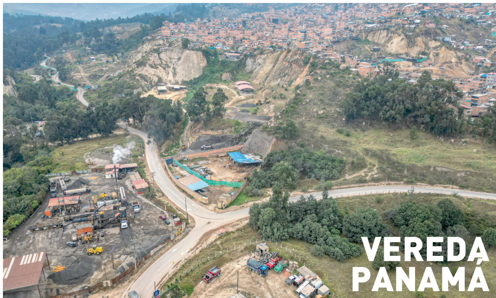
Construcción Via Soacha - Sibaté.
