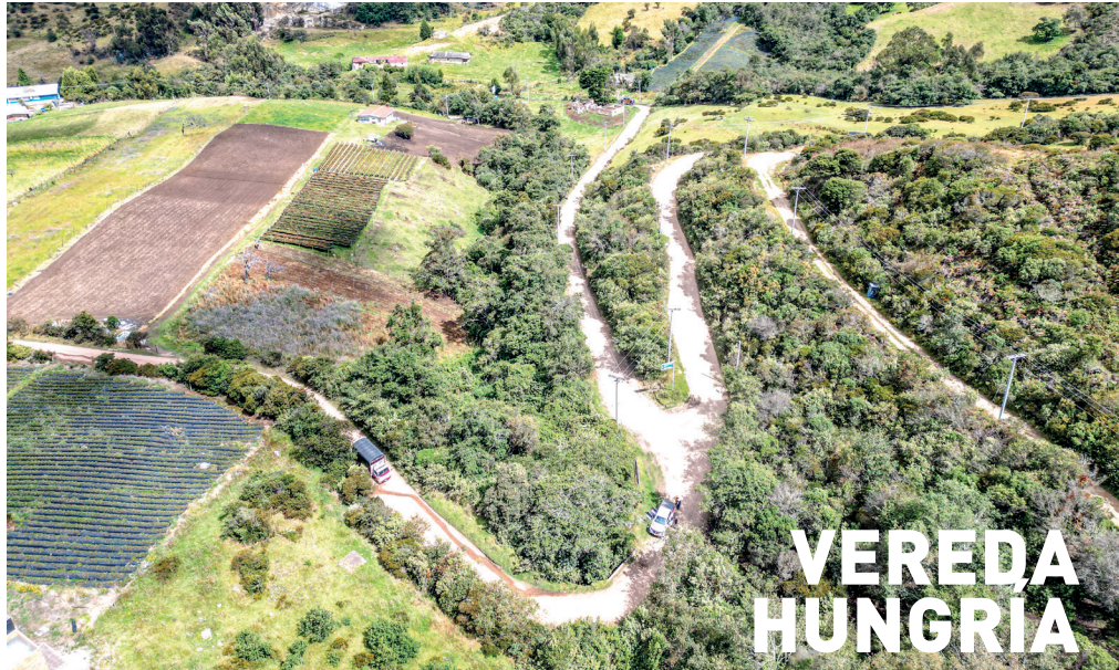
Construcción Via Soacha - Sibaté.
